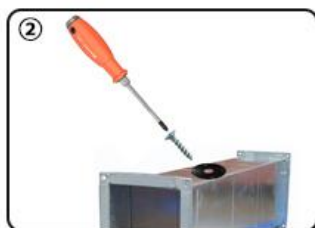
用螺丝将法兰盘固定在排风管上
