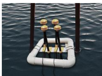
(2) PVC管材支架安装
