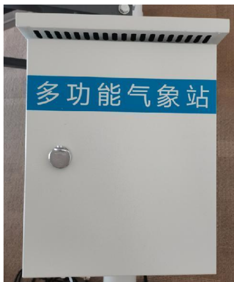
安装完成正面图
