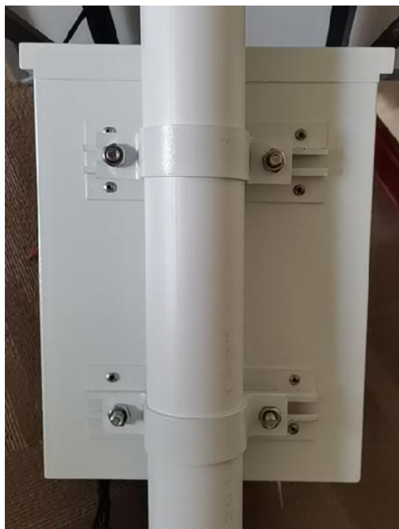
安装完成背面图
