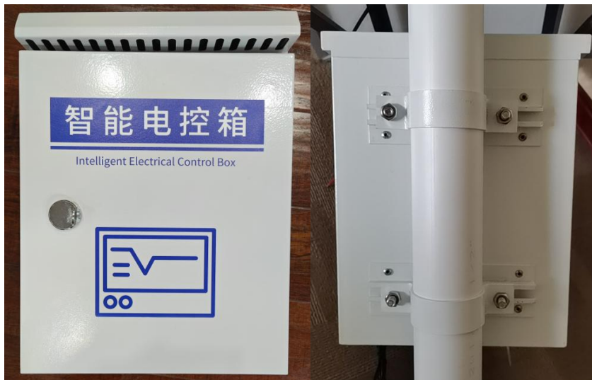
安装完成正面图
