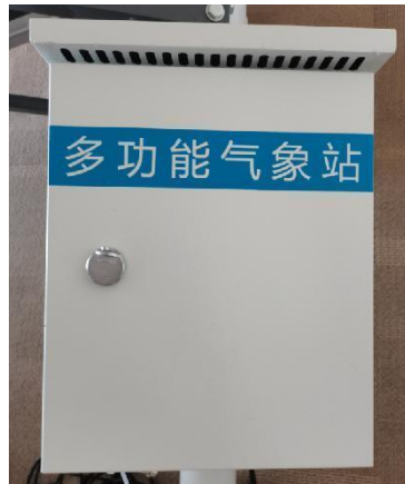
安装完成正面图
