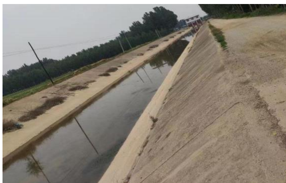
选择流速平稳的渠道段装
