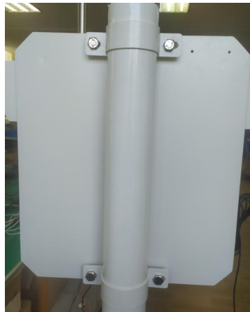
安装完成背面图
