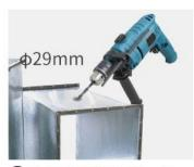
① 在排风管上打一个 直径29mm的孔
