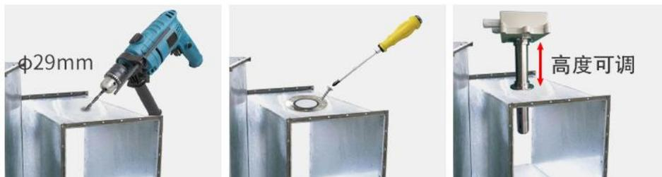
① 在排风管上打一个直径29mm的孔
